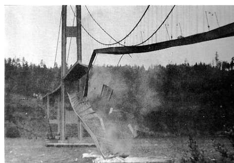
شکل ۱- تخریب پل تاکومانروز در امریکا بر اثر وقوع پدیده تشدید در ارتعاشات [۱۲]
