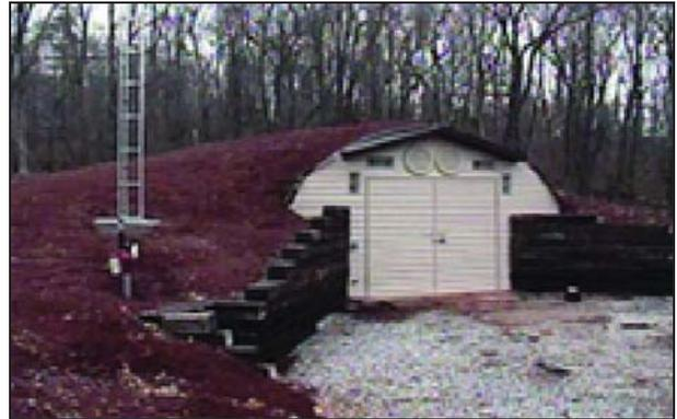
شکل ۲- نمونه‌ای از انبار نیمه‌مدفون
