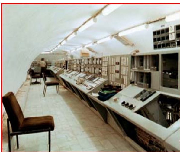
شکل ۲- ساختمان کنترل پالایشگاه شیراز بعد از بازسازی [۳۳]
