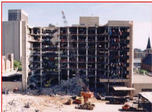
شکل ۸- نمونه‌ای از انهدام پیشرونده ناشی از انفجار [۲۹] [۲۰]
