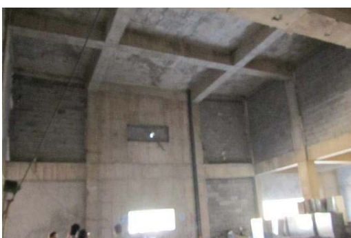
شکل ۳- سیستم سازه‌ای دوگانه سازه مرکز کنترل
