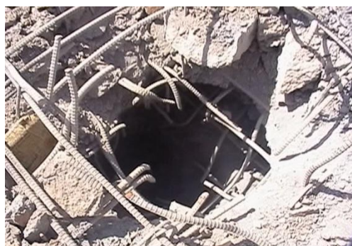
شکل ۷. تخریب سازه ورودی شفت یکی از پناهگاه‌های تونلی (جنگ آمریکا - عراق)
