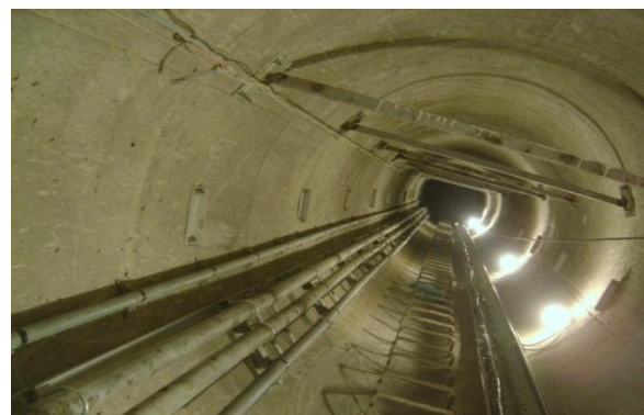
شکل ۱۵. پله خروج اضطراری و تأسیسات در یک شفت تهویه
