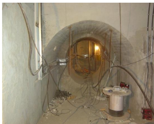
شکل ۹. مسیر اتصال شفت به سازه مرکزی تونل
