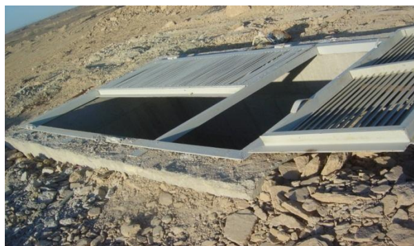
شکل ۴. یکی از اشکال ظهور شفت تونل در سطح زمین
