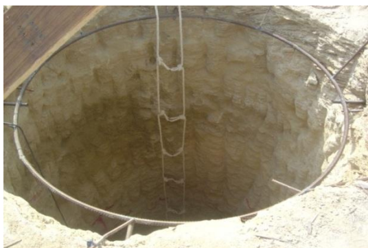
شکل ۵. نمایی از شفت حفاری شده بدون نگهداری اولیه
