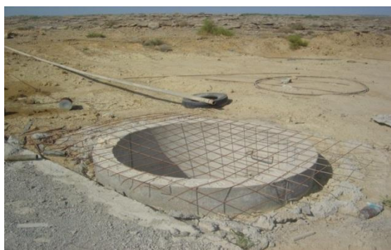
شکل ۶. نمایی از یک شفت حفاری، تحکیم و لاینینگ شده
