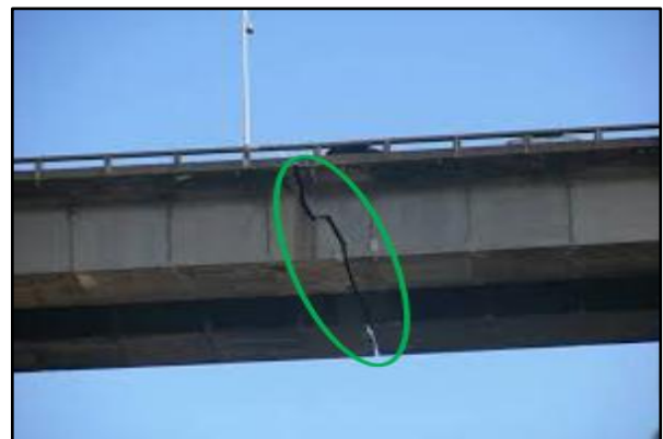
شکل (۱۰): نمایی از ترک خوردگی پل که با استفاده از حسگر \Phi -OTDR قابل شناسایی است.
