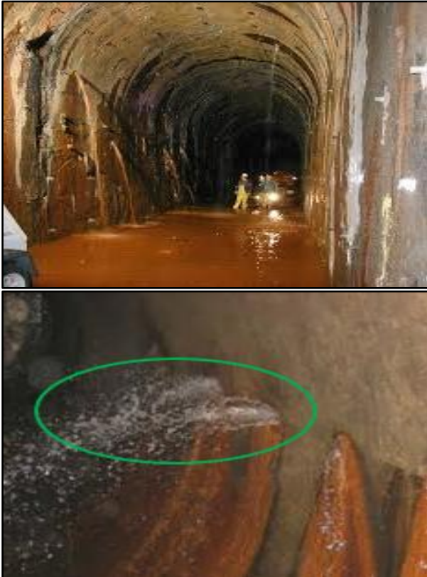
شکل (۱۱): ترک خوردگی تونل که با استفاده از حسگر \Phi -OTDR قابل شناسایی است.
