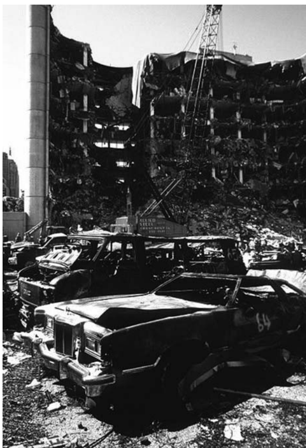
شکل ۱- انهدام بخش‌هایی از ساختمان فدرال، شهر اوکلاهما، امریکا، ۱۹۹۵
