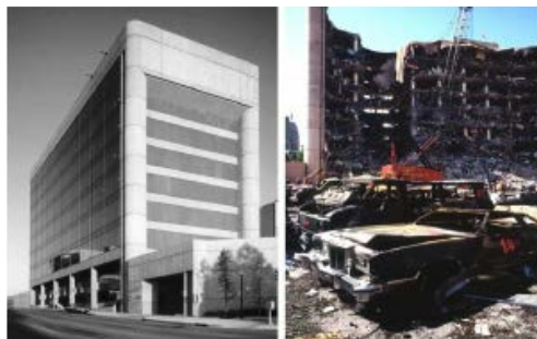
شکل (۱): خرابی ساختمان آلفردمورا شهر اوکلاهما در سال ۱۹۹۵ [۱]
