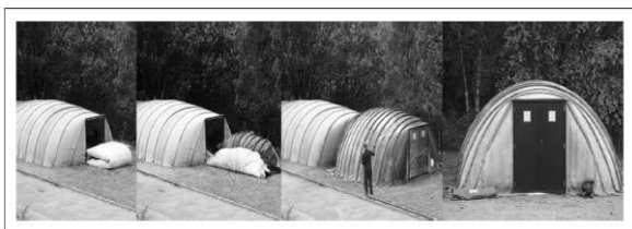
شکل (۲): برپاسازی چادر بتن پارچه‌ای [۱۲]
