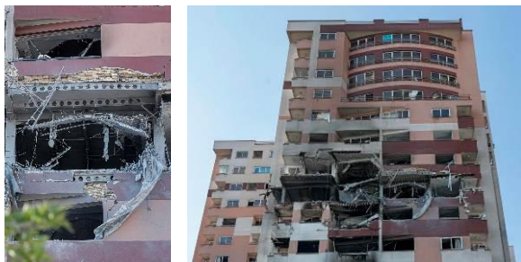
شکل (۱۸): آسیب پرتابه انفجاری به نمای جنوبی ساختمان. مجتمع مسکونی سرو [۶۳].
