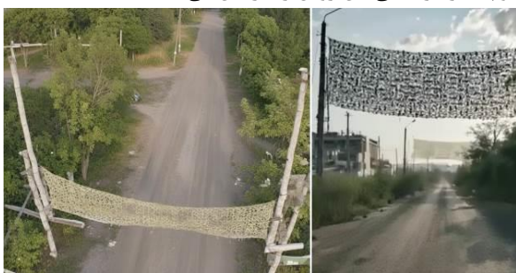
شکل (۷): نصب تورهای ضدپهناد عمودی توسط روس‌ها بر فراز جاده‌ها با استفاده از تیرهای برق در منطقه باخموت [۴۶].
