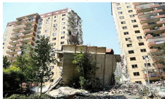
شکل (۱۷): تخریب کامل بخش مورد هدف در ساختمان ۱۵ طبقه. شهرک شهید چمران [۶۱].
